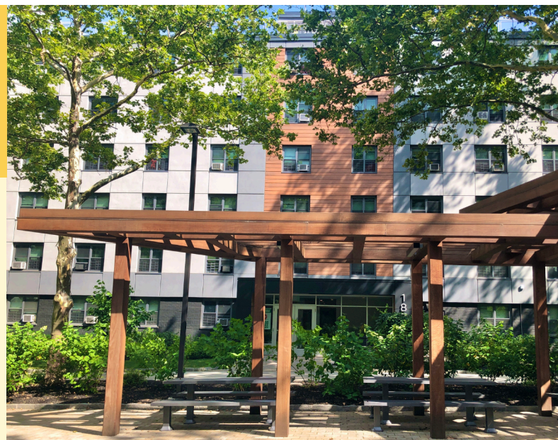
Baychester Houses - 住宅区 - 经翻新的住房单位和室外空间
