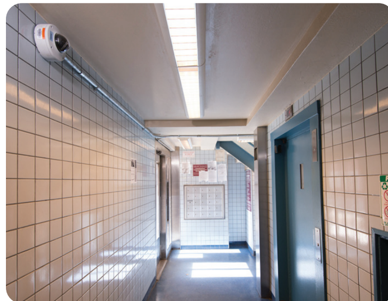
照明良好、配備安保攝像頭且視野開闊的走廊
