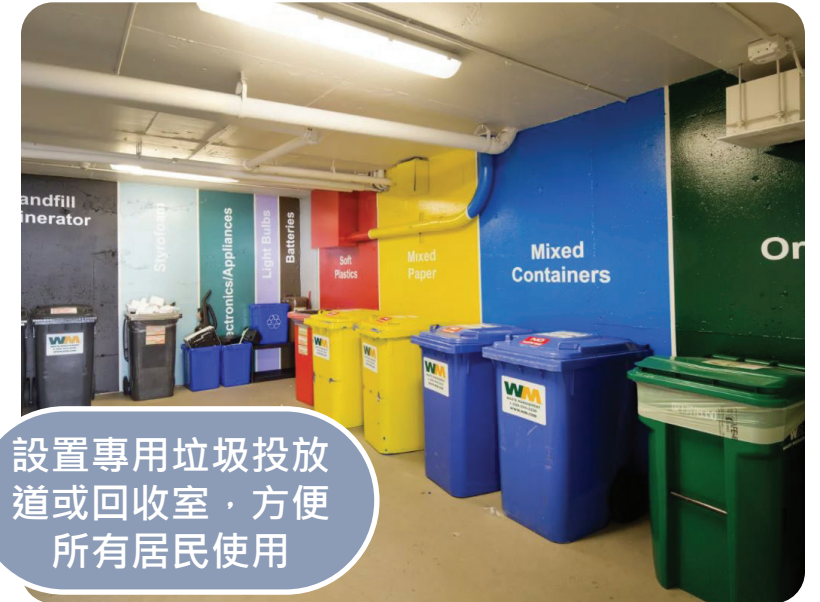
各樓內的垃圾處理設施
