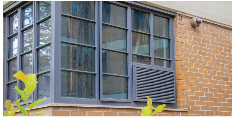
Williamsburg Houses 住宅區: 新窗戶 來源: NYCHA
