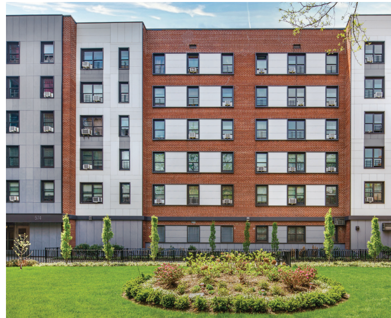
572 Warren Street Houses 住宅区: 升级后的外墙 来源: NYCHA
