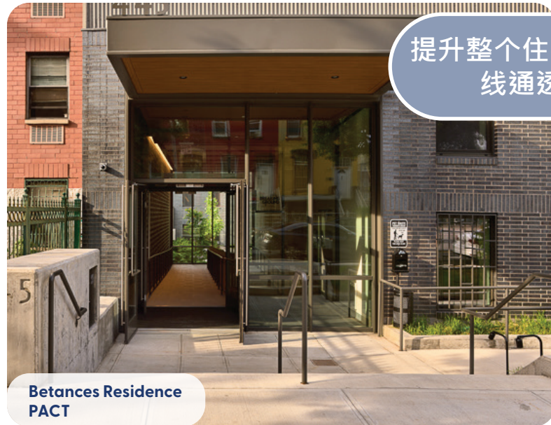
无障碍入口，通行动线顺畅
