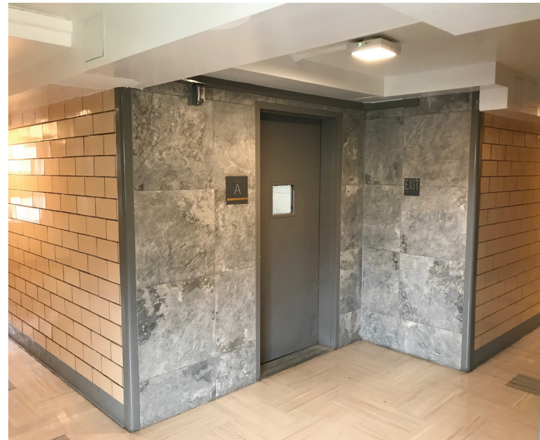
Ocean Bay Houses 住宅区: 翻修后的走廊 来源: NYCHA
